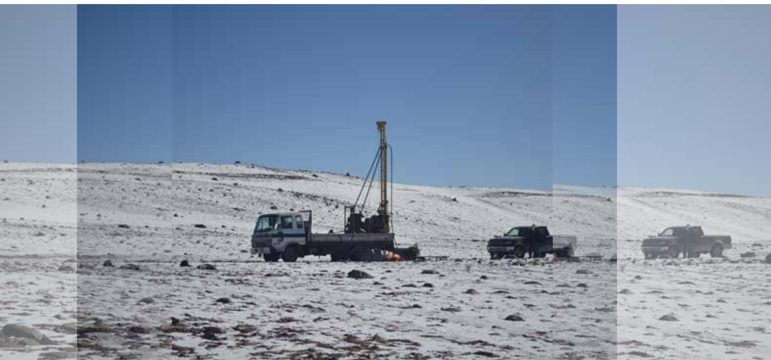
Trabajos en Laguna Colorada
